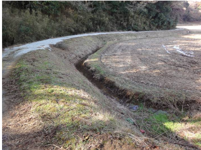
写真 5-1(1) 水田と農道の間 の承水路
